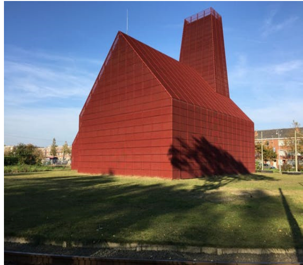
De Aardwarmtecentrale, een ontwerp uit 2012 van Splinter architecten. Foto: Haagse Aardwarmte Leyweg
